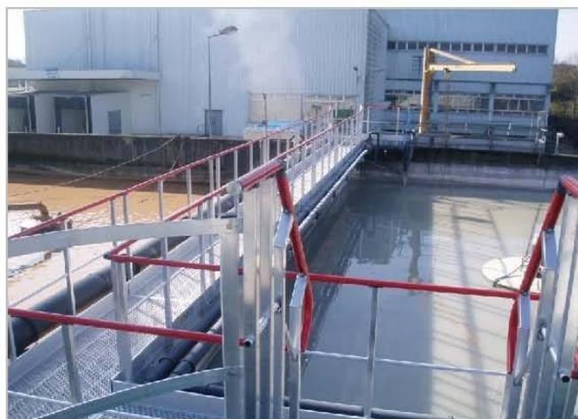
Ensemble de passerelles sur mesure en station de traitement des eaux en structure tout aluminium 100 x 30 mm :
