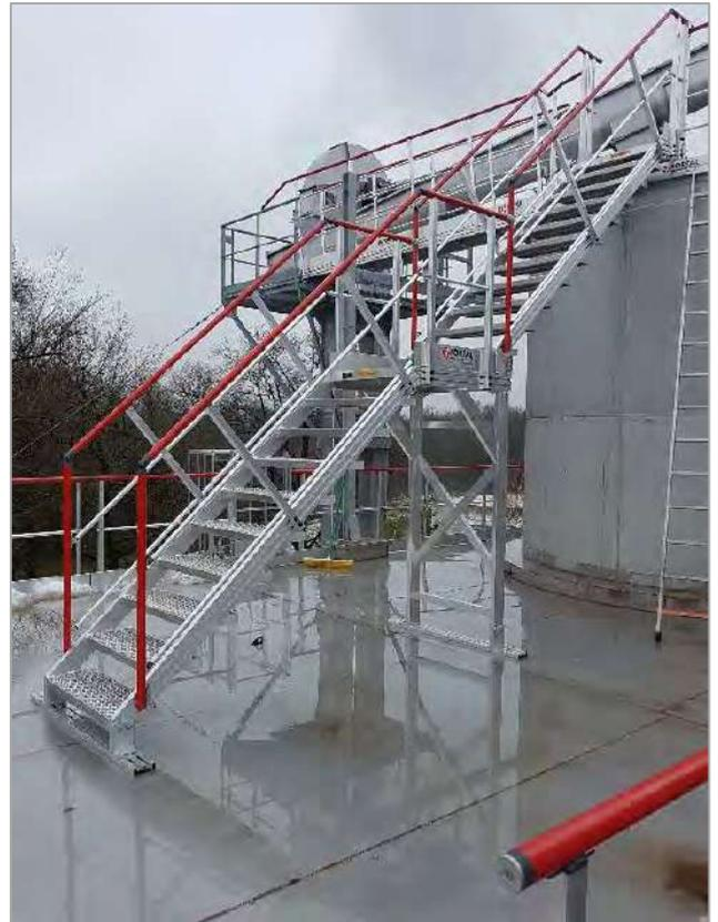
Ci-contre, réalisation d'un escalier à palier – marches caillebotis - pour accès direct sur le dessus d'un silo.
